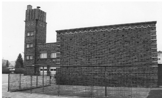
Abbildung 1: Feuerwehrgebäude, 2012; Foto: Uwe Kulke
